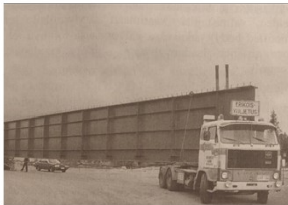
Kuva 6. Teräspalkin erikoiskuljetus (Teräsrungon asennus 1997).
