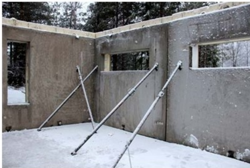
Kuva 5. Betonielementtien asennuksen aikaista tuentaa (Rakentaja.fi).
